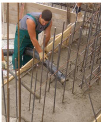
Die P 718 fördert u. a. Feinbeton bis zu einer Korngröße von 32 mm.
